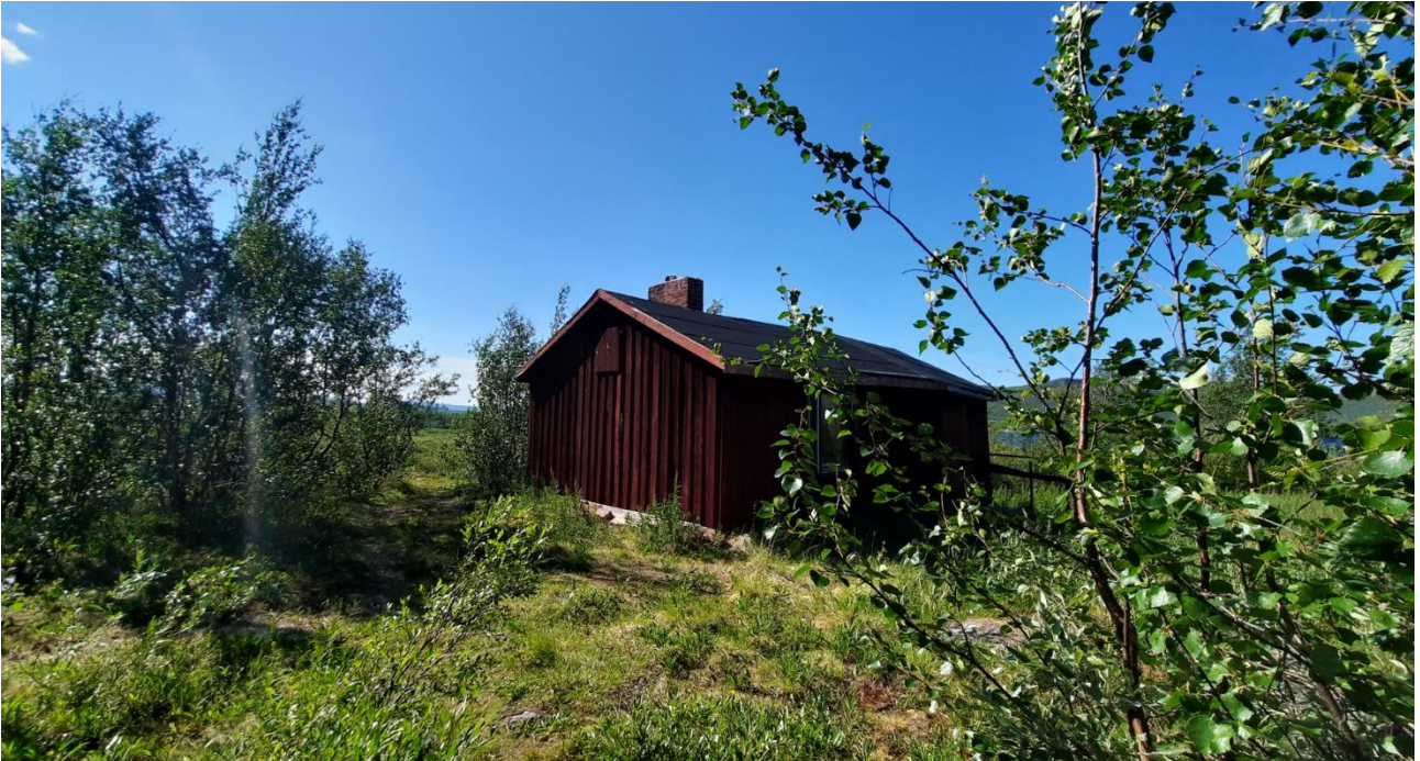
Kuva 52. Alueella on rakennuksia.
