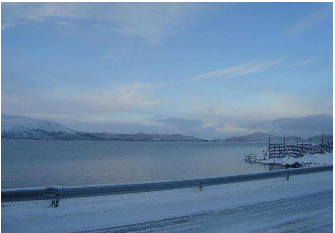
Kuva 57. Näkymä Ailakkajoen sillalta kohti Ala-Kilpisjärveä.
