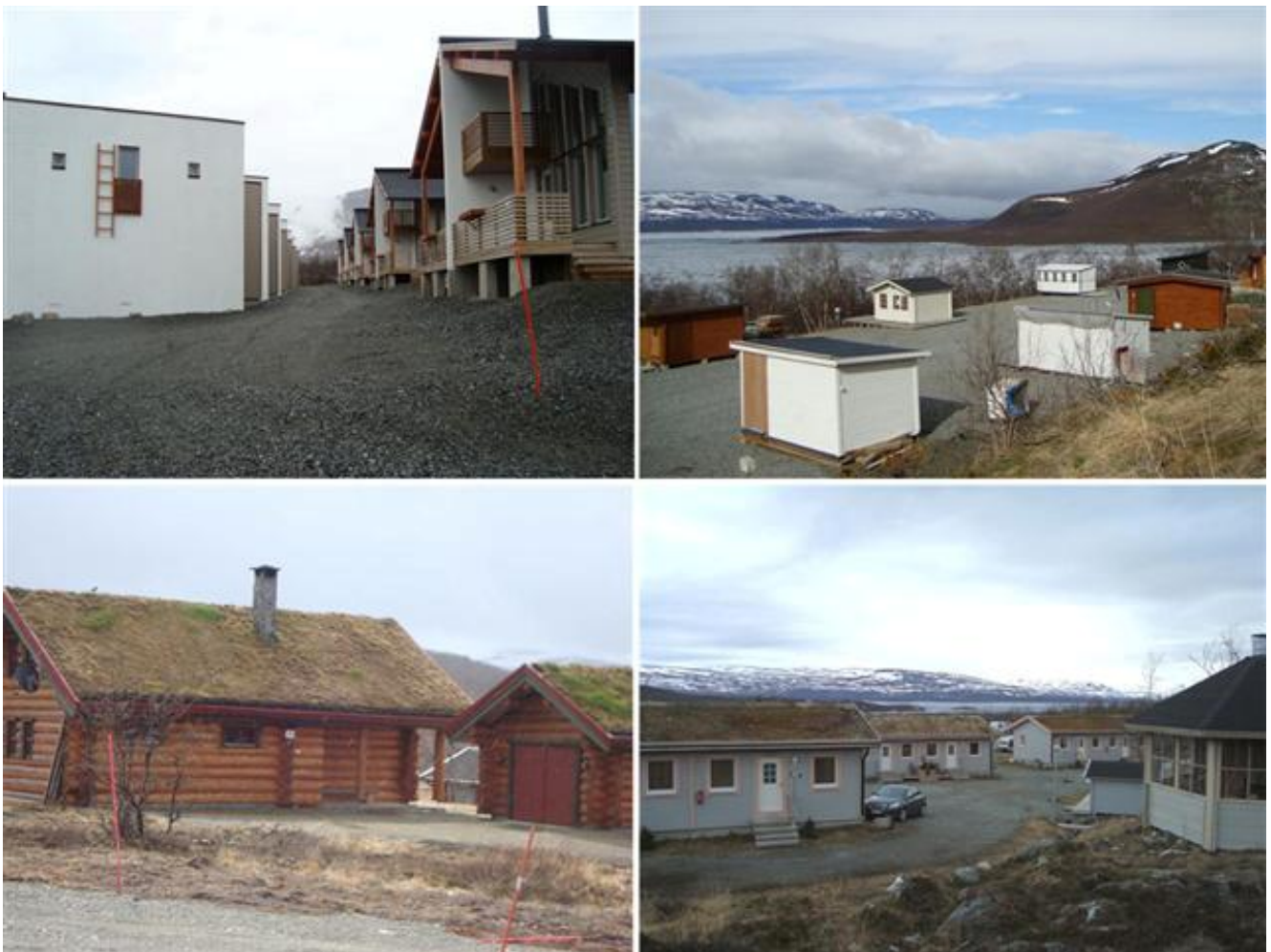
Kuva 26. Erityyppisiä esimerkkejä rakentamisesta matkailupalveluiden ja loma-asumisen alueilla. - Vas.ylh.:keskustan tiivis, moderni loma-asuntoalue, joka erottuu omana kokonaisuutenaan alueen maisemakuvassa, oik. ylh.: rakenteita Saananjuuren matkailuvaunujen alueella, vas. alh. lomarakentamista Salmivaaran alueella, oik. alh. Haltinmaan majatalon majoitusrakennuksia.
