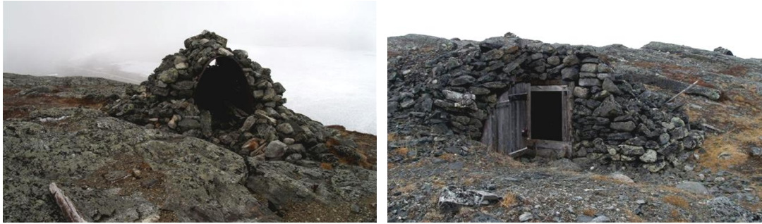
Kuva 36. Saanan laella sijaitseva saksalaisten rakentama tähystysasema (vas.) on alueen sotahistoriallisista kohteista parhaiten säilyneitä. Se on konstruoitu paraboloidisesta aaltopellistä ja luonnonkivistä. Sisätilassa on puiset laverit, joihin matkailijat ovat jättäneet puumerkinsä. Tähystysasemaan (oik.) liittyy samalla tekniikalla rakennettu sirpalesuoja ja tilapäinen majoitustila.
