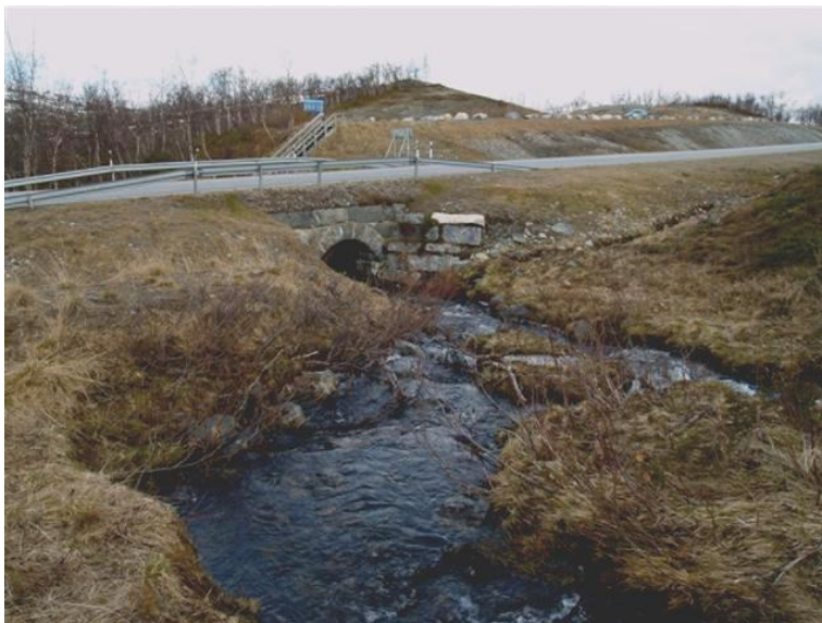
Kuva 35. Lähellä valtakunnanrajaa sijaitseva Ahdaskurun silta on ollut valtakunnallinen tiemuseokohde 1980-luvun alusta lähtien. Taustalla pulterikivin rajattu pysäköintialue. Tiepenkereet saavat näin pohjoisessa kasvipeitteensä hitaasti, jos koskaan.
