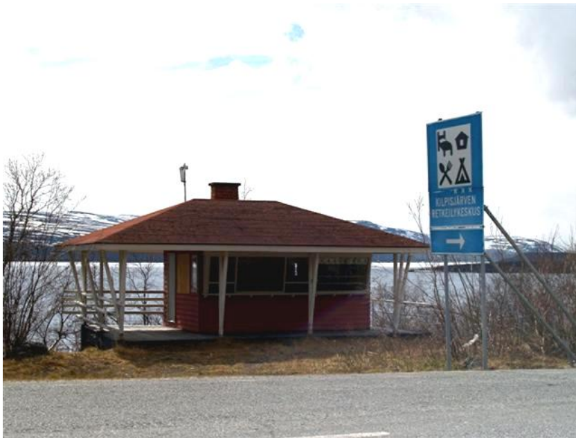
Kuva 44. Retkeilykeskuksen kioskii Käsivarrentien länsipuolella. Rakennuksella on keskeinen asema alueen matkailuhistoriassa. Olisi toivottavaa, että sille löytyisi käyttöä. Nykyiselläänkin viihtyisä katos tarjoaa suojaa vaikkapa eväiden nauttimiseen. Mikäli rakennukselle ei löydy kioskiryttäjää, voidaan laajoja ikkunoita käyttää esimerkiksi alueen retkeilyhistoriaa tai luontokohteita valottavan näyttelyn esittelyyn.
