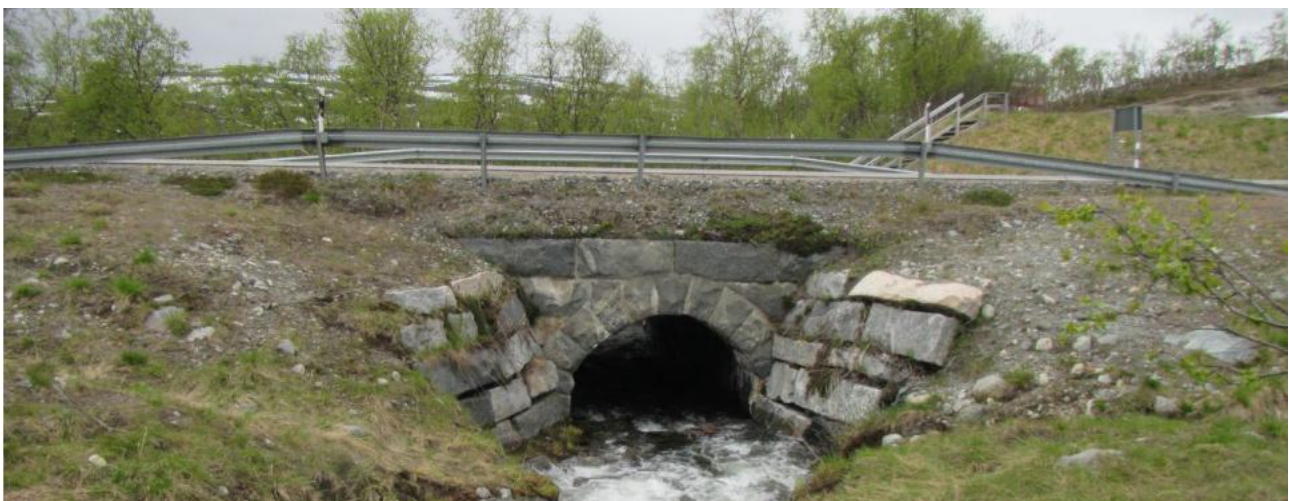
Ahdaskurun silta (kuva: Pentti, M. & Soosalu, L., 2022, Ahdaskurun silta, Kilpisjärvi, Enontekiö: Museosillan kunnossapitosuunnitelma).
