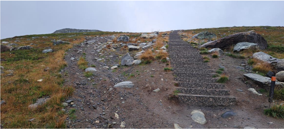
Kuva 2 Portaات helpottavat kulkua ja saavat kävijöitä pysymään reitillä. Saanan huipulle vievä, Natura-alueen ulkopuolella oleva reitti.
